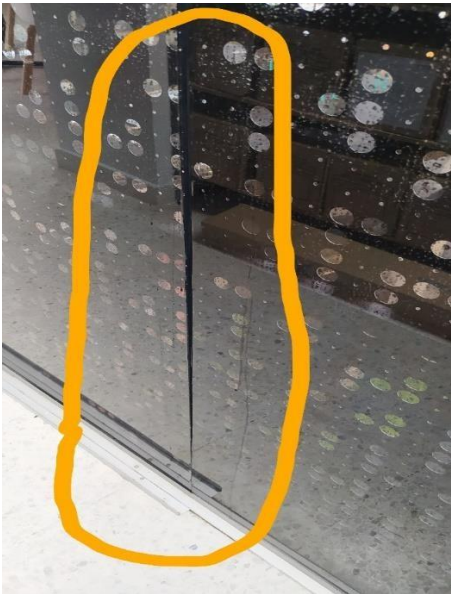
Imagen 4. Condiciones espacio de Archivo Central RAP
