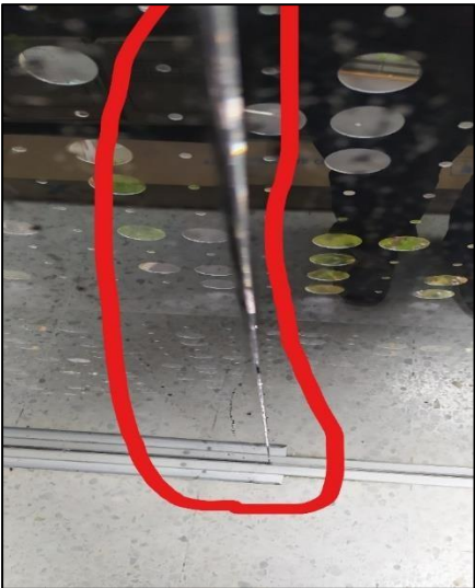
Imagen 3. Condiciones espacio de Archivo Central RAP
